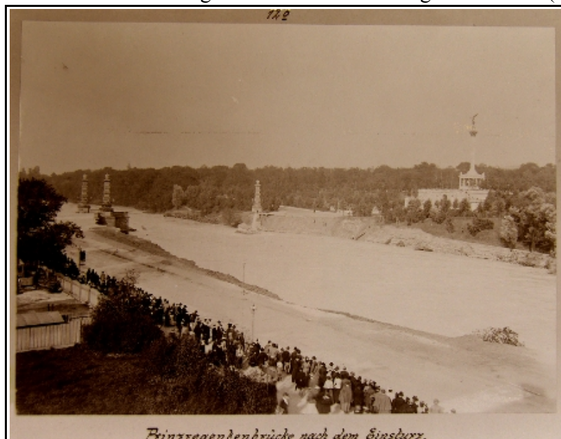
Abb. 42: Hochwasser 1899: Die eingestürzte Brücke mit Friedensengel. An beiden Ufern sind große Abbrüche erkennbar.
